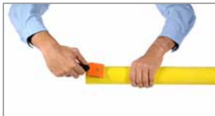
5. Rasar la zona de soldadura del tubo.
