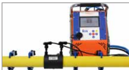
11. Inicio de la soldadura.
