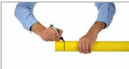
7. Marcar la profundidad de inserción del tubo.
