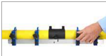
8. Utilizar el alineador para evitar movimientos del tubo.
